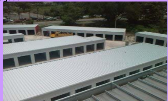
Techo sobre Mini Warehouse de Carolina
