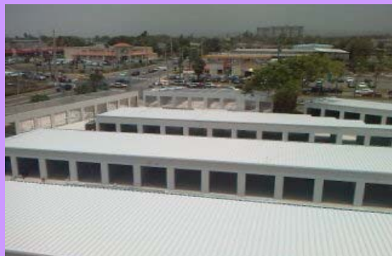
Techo sobre Mini Warehouse de Carolina
